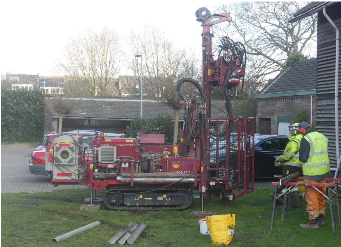
Afbeelding 15 de sonic drill tijdens het gebruik (A. Gazenbeek januari 2021).
